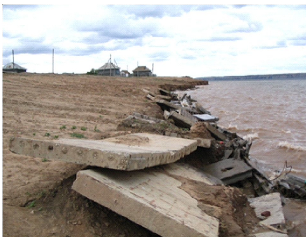
Рис. 1. Разрушение берегоукрепления в п. Кислово
